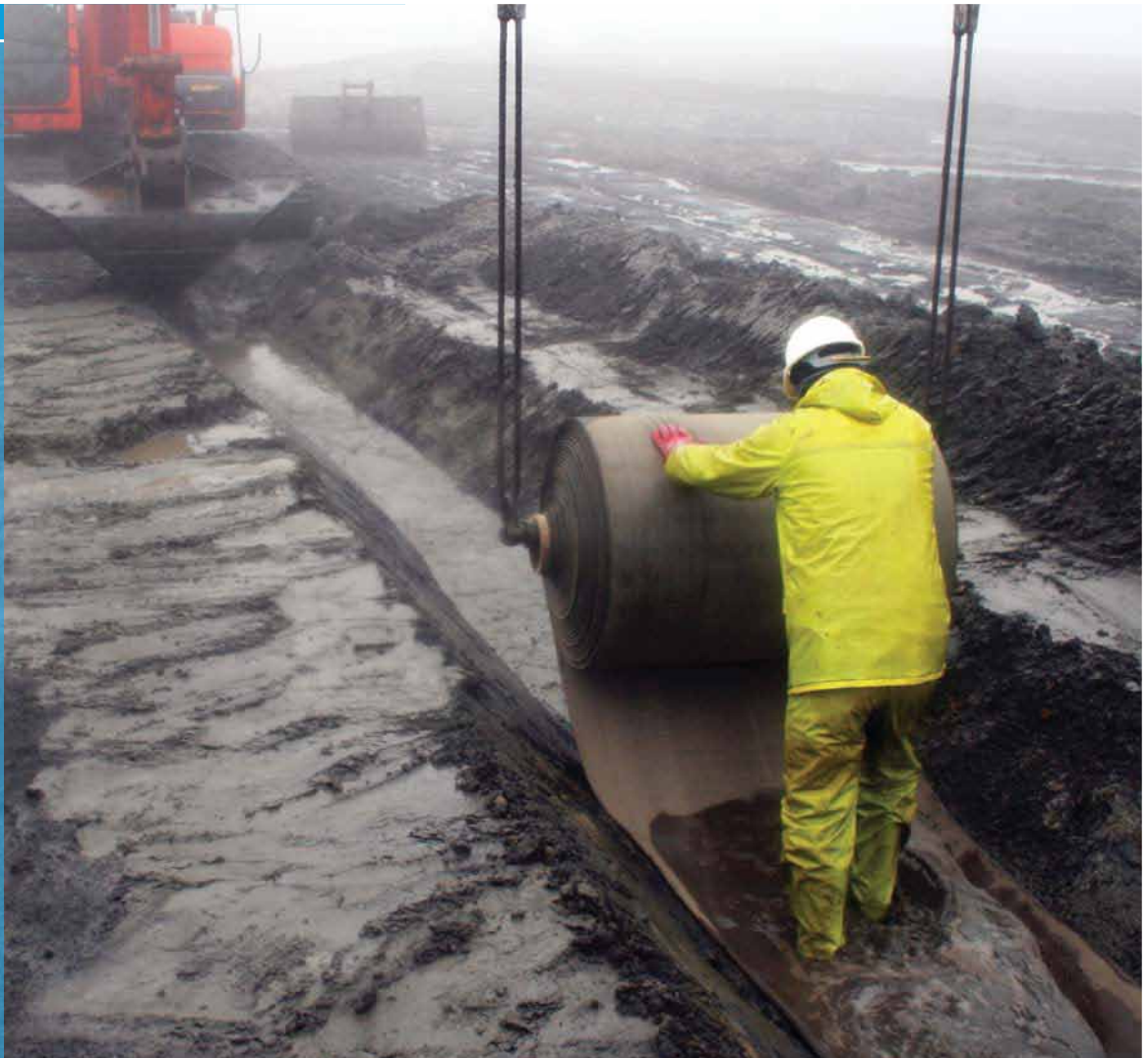
Instalación de lámina de CC13 con la cuneta inundada
