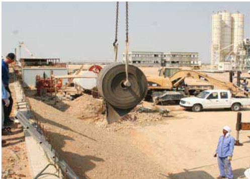
CC4 or CC8 en longitudes de 200 y 110 m respectivamente puede ser colocado con un camión pluma
