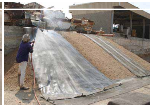
CC se hidrata una vez fijado en su posición definitiva. Se pueden disponer unos aspersores en la cabeza
