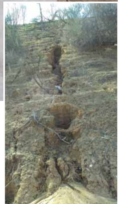
Detalle del estado previo de los taludes
