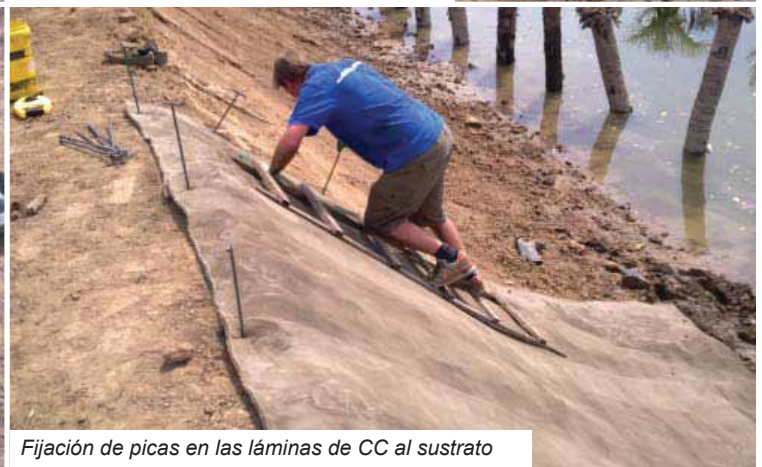
Instalación vertical de los rollos manuales de CC8
