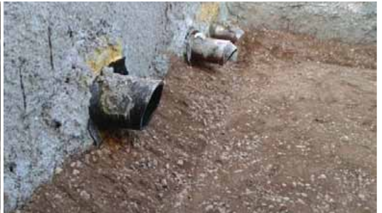
Relleno de la base con zahorra compactada
