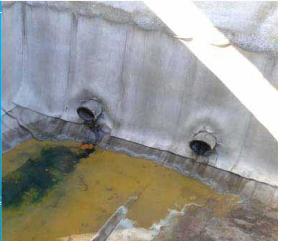
Revestimiento completado después de 9 horas de trabajo
