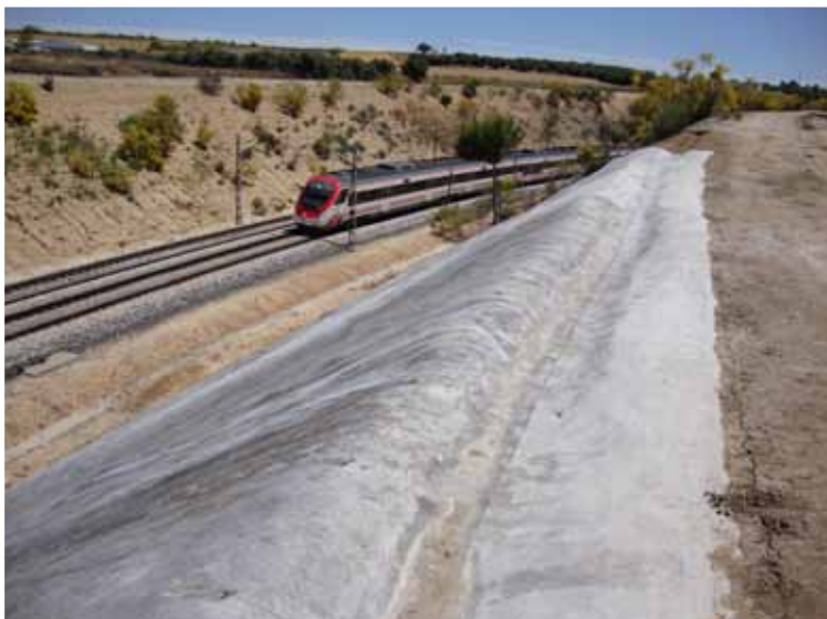
Vista de la prueba de protección de talud contra las perforaciones producidas por los conejos en la línea de cercanías C-4, T.M. Parla (Madrid).
