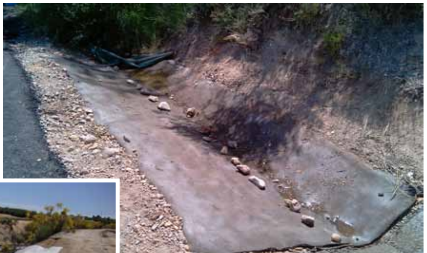
Vista de la prueba de protección de talud contra las perforaciones producidas por los conejos en la línea de cercanías C-4, T.M. Parla (Madrid).
