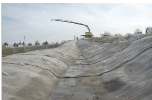
Detalle del revestimiento de la cuneta de guarda
