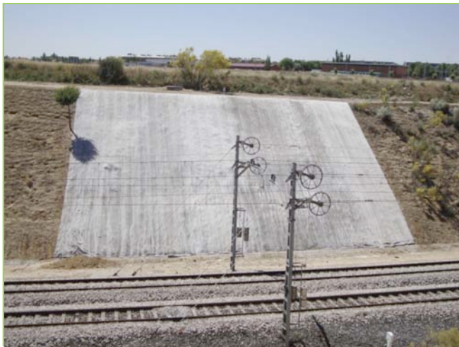
Vista general del talud reparado
