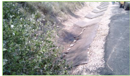
Ejecución de cuneta con la Manta de Hormigón frente a la ejecución de cuneta tradicional
