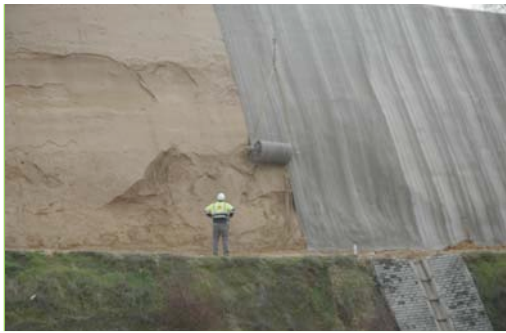
Vista general de la instalación de Manta de Hormigón
