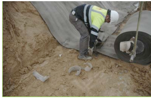
Detalle del corte de la Manta de hormigón
