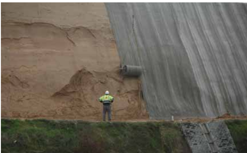
Vista general de la instalación de la manta de hormigón en la actuación realizada en la línea C-4
