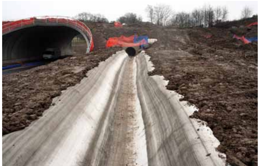
Aplicación de la manta de hormigón en el revestimiento de un canal
