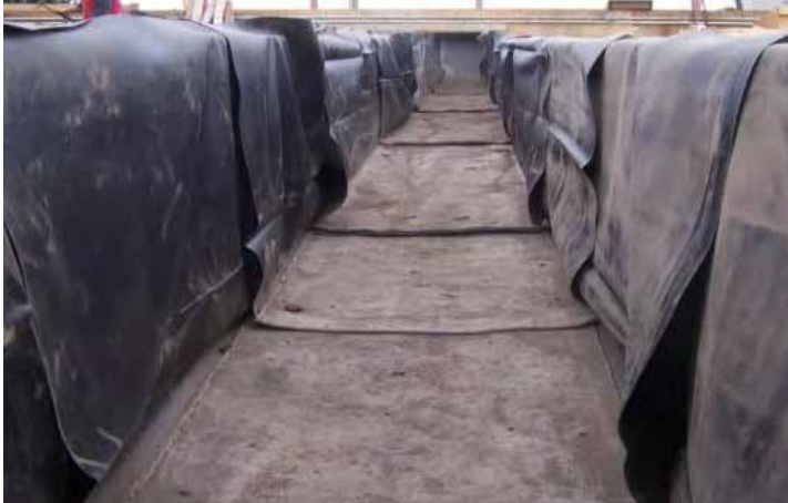
Manta de hormigón durante la instalación
