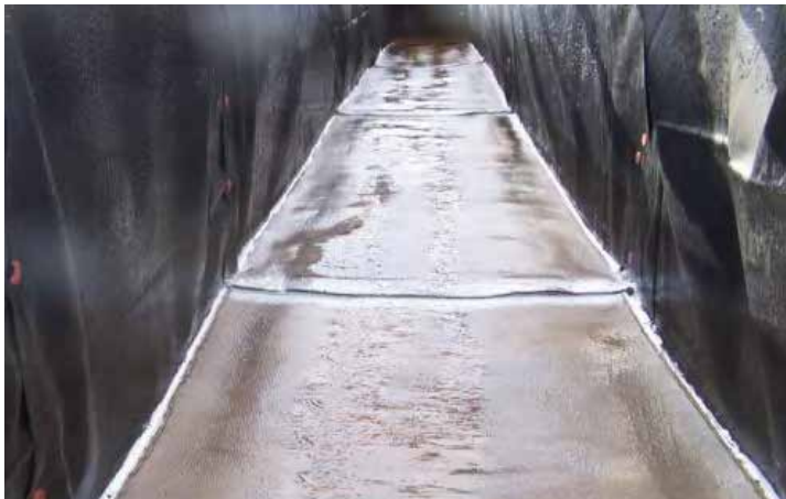
No se evidenció separación en las uniones
